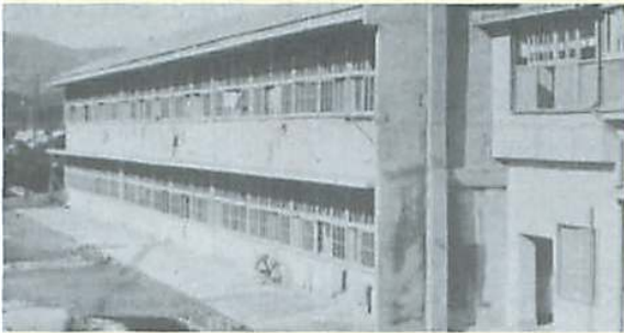
昭和28年度建設、一般病棟の南側(昭和29年12月6日)
