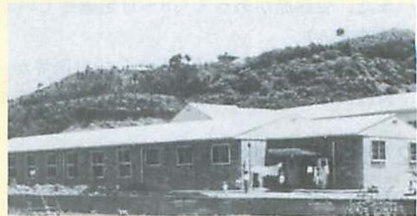
外科病棟(コンクリートブロック造り)(昭和30年6月10日竣工)
