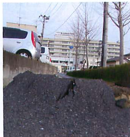
マンホール突出
