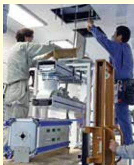
■シーリングペンダント取付けの様子
